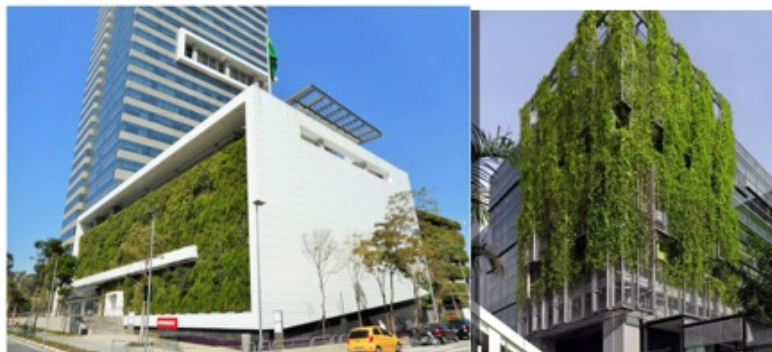
Fig. 9: exemplos de parede verde com vegetação natural (à esquerda) e brise vegetal (à direita)
