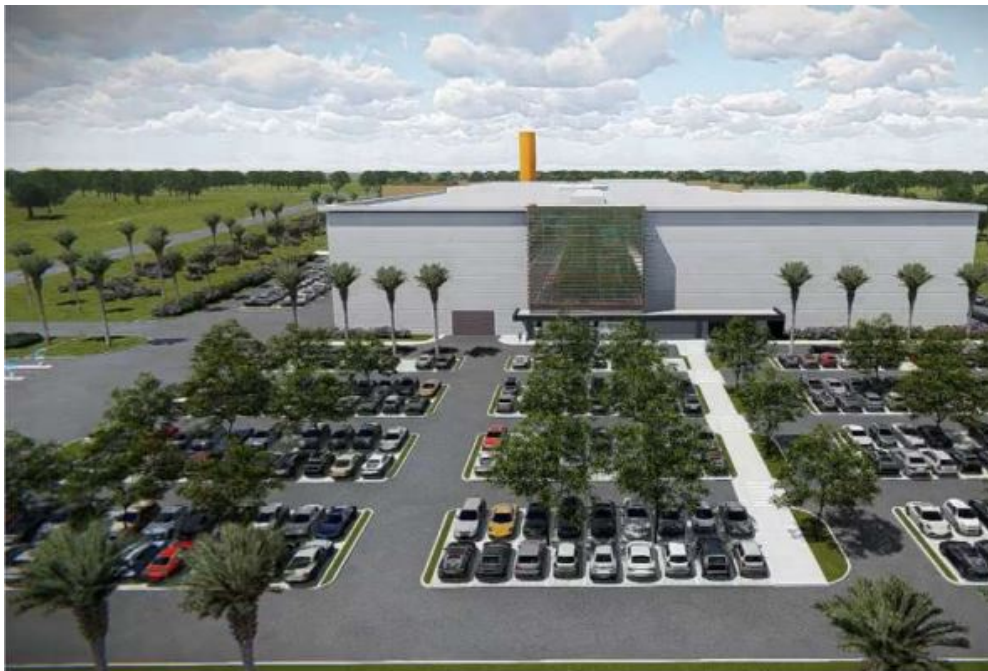
Fig. 03 - Fachada do empreendimento voltado para o centro tradicional de Planaltina
